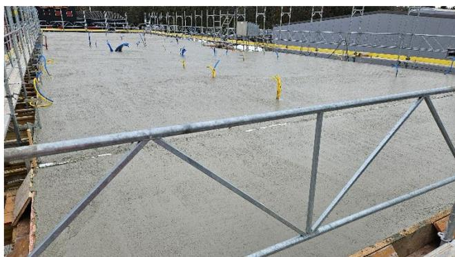
Figure 2 : Bétonnage de la dalle
