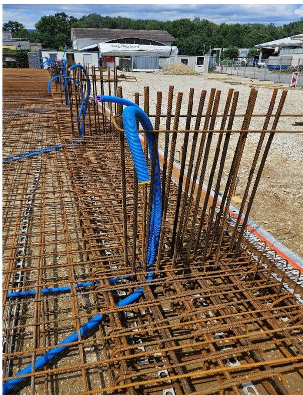
Figure 4 : Armature de chaînage du radier
