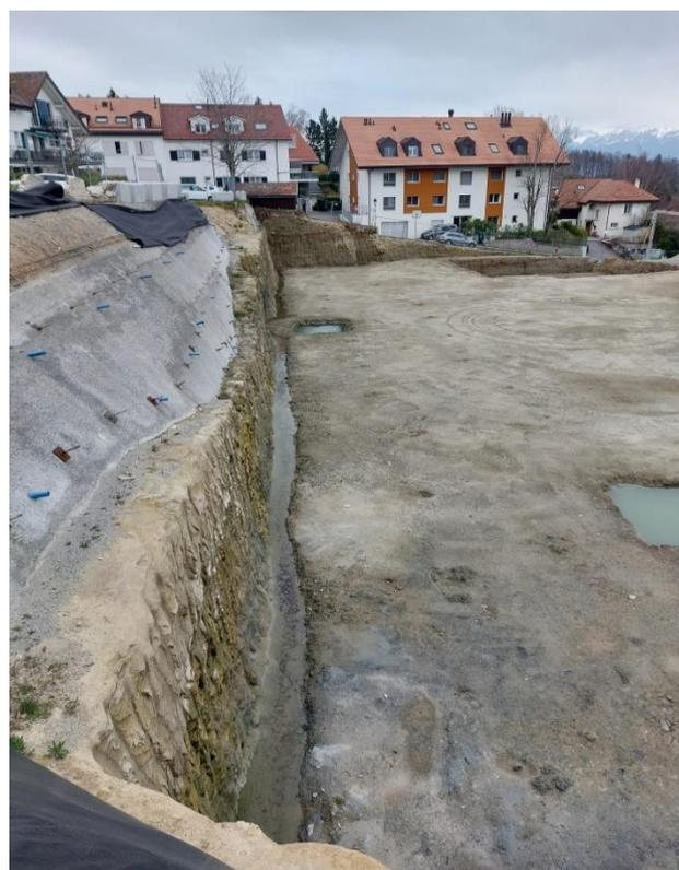
Figure 4 : Paroi ancrée et terrassement
